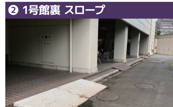
② 1号館裏 スロープ 段差解消の傾斜が3つ設置されています。白の傾斜は比較的通行しやすいです。
