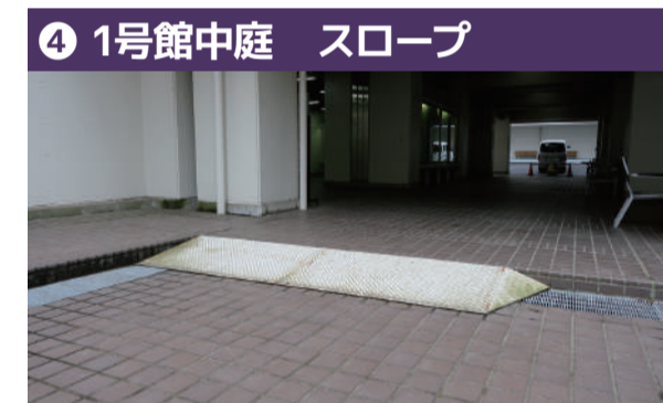
④ 1号館中庭 スロープ 段差解消の傾斜が、約1/7勾配(9°)でかなり急であるため、注意が必要です。
