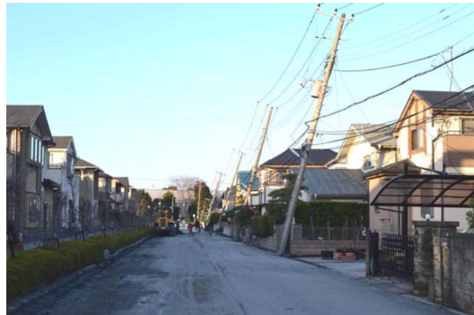
習志野市袖ヶ浦6丁目住宅地の被害 2011.3.13
