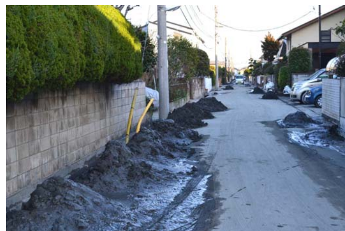
習志野市袖ヶ浦6丁目住宅地の噴砂被害 2011.3.13
