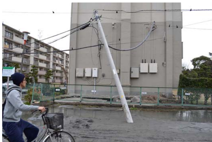
習志野市袖ヶ浦 2 丁目団地の液状化による被害 道路が地盤沈下しことで一時は付近は泥の沼と化した。 2011.3.14
